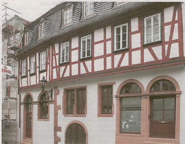
Begehbare Geschichte: Das Fachwerkhaus in der Aschaffener Dalbergstraße 72 zählt zu den Gebäuden, für die es am Tag des offenen Denkmals Führungen gibt. Das im Kern fast 500 Jahre alte Haus wurde 2010/11 umfassend saniert und erhielt den Denkmalpreis des Bezirks Unterfranken.
